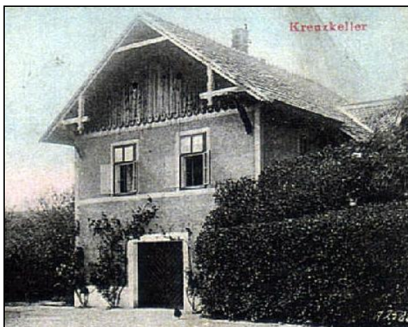
Původní vchod do Křížového sklepa, asi okolo roku 1900 (MSV)
