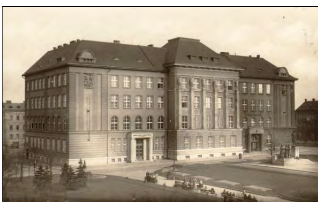
a novostavba vlastního paláce filiálky Plzeň, 1932 (MCP, P1132)
