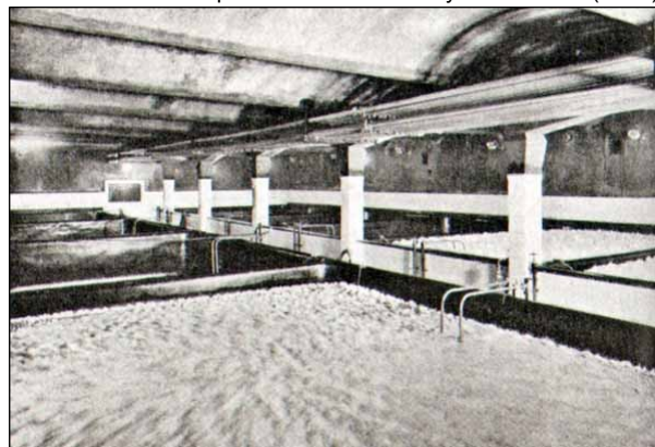
Železobetonové kádě ve spilce Městského pivovaru, 1930 (AMO)
