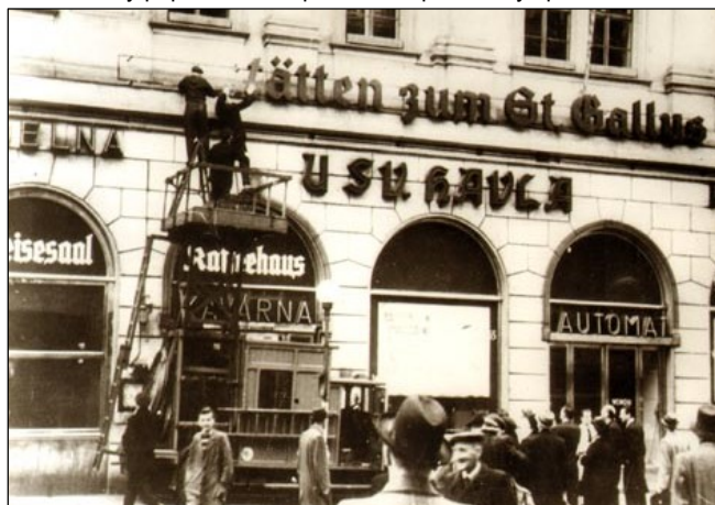
Ničení německých nápisů na fasádě restaurace, květen 1945 (T9394)
