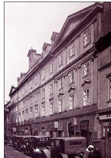
Nové sídlo ČAT v Panské ulici čp. 892
