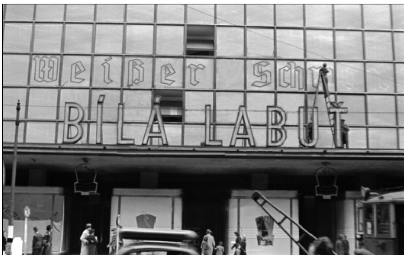
Odstraňování německých nápisů z průčelí paláce v květnu 1945 včetně a.s.
