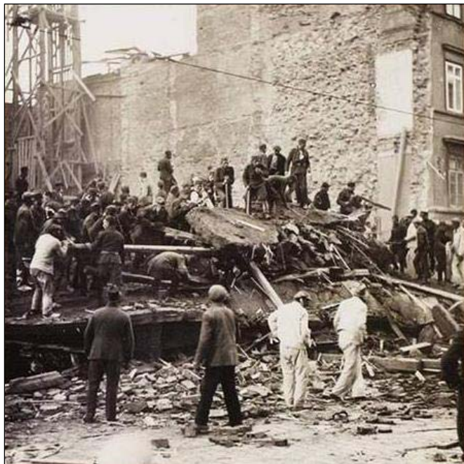
< Fotografie z odklizení sutin po neštěstí zřícení domu na nároží ulice Biskupská a Na Poříčí 9. října 1928 (foto Archiv HZS Praha)
