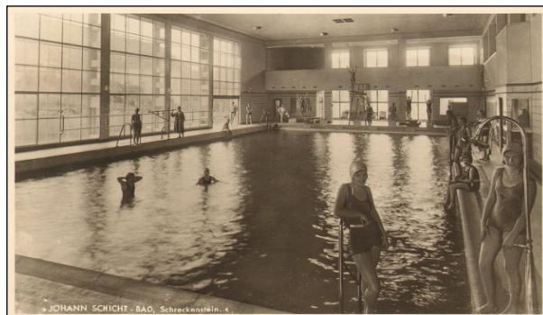
Lázně Jana Schichta ve Střekově a vnitřní plavecký bazén, 1932
