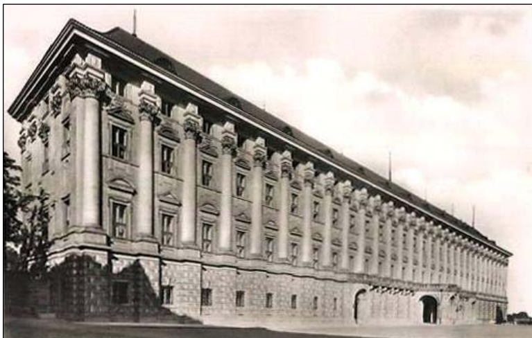
Budova Černínského paláce upravená podle projektu arch. Pavla Janáka (1933)
